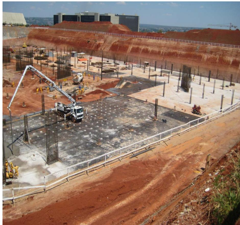
Foto 15 – Concretagem - Piso 3º Sub-solo
