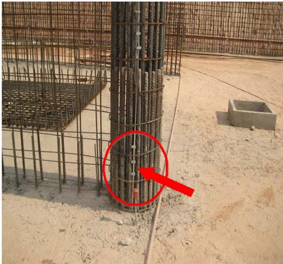
Foto 20 – Aterramento e proteção contra descargas atmosféricas
