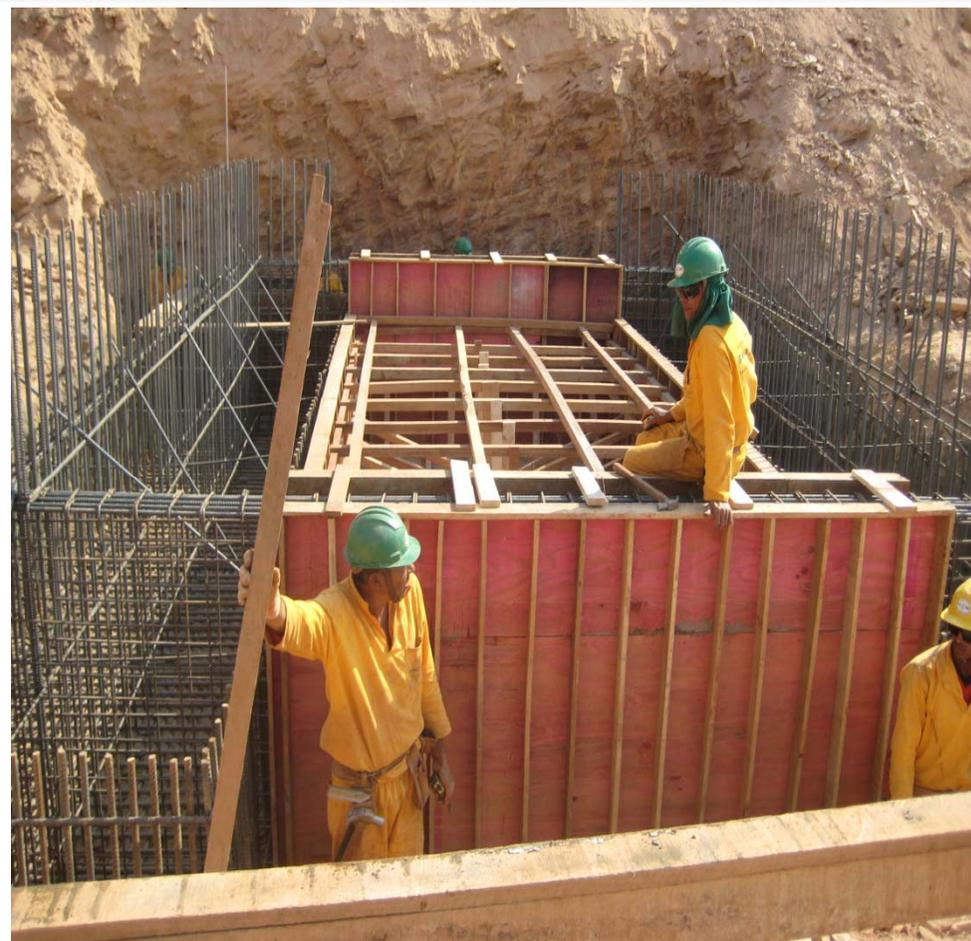
Foto 7 – Forma/Ferragem de Sapatas
