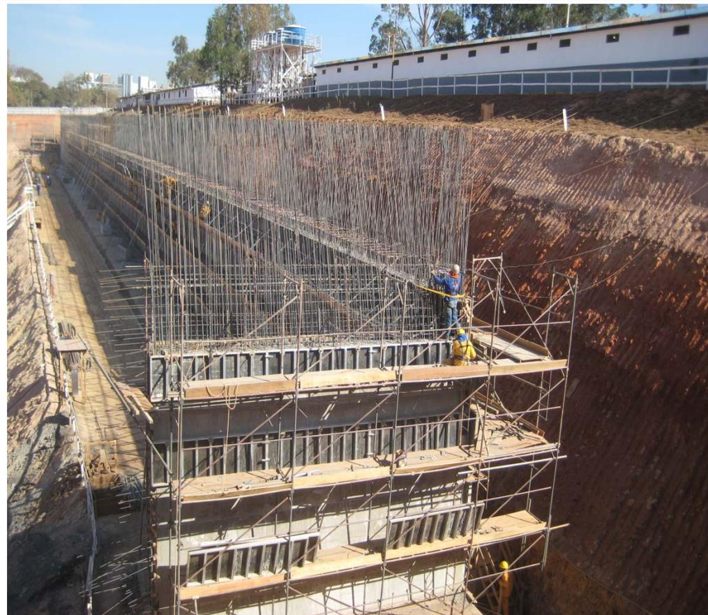
Foto 11 – Forma/Ferragem/Concreto – Muro de Arrimo Eixo 1
