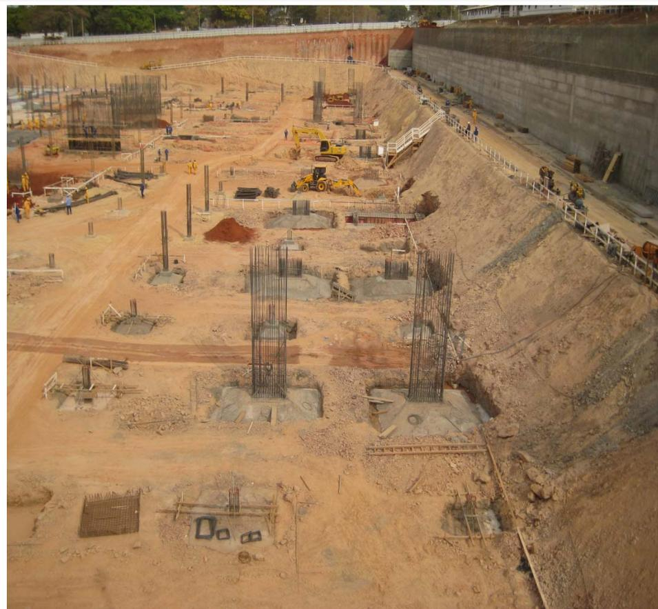
Foto 9 – Forma/Ferragem/Concreto de Sapatas
