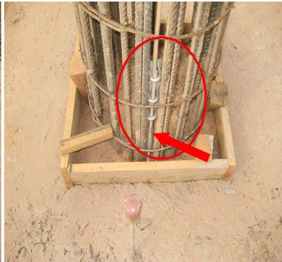
Foto 21 – Aterramento e proteção contra descargas atmosféricas
