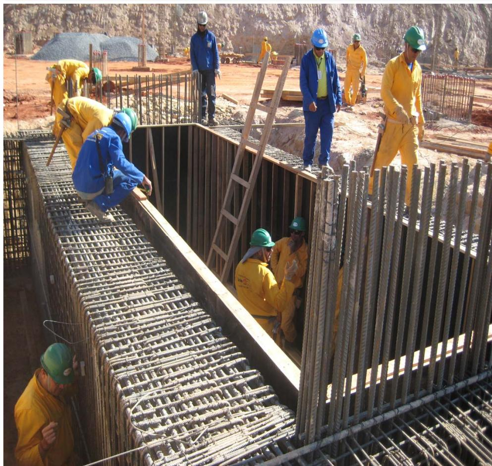
Foto 6 – Forma/Ferragem de Sapatas
