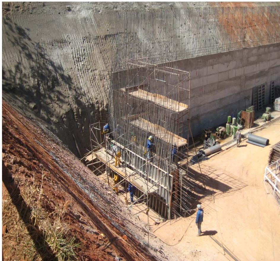
Foto 10 – Forma/Ferragem/Concreto – Muro de Arrimo Eixo 1
