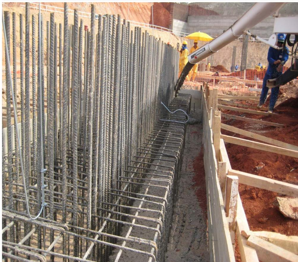
Foto 8 – Forma/Ferragem/Concreto de Sapatas
